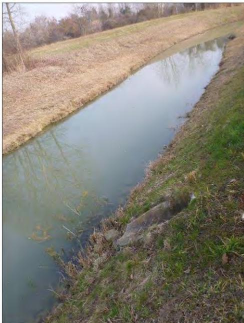
Immissione acque fossato a cielo aperto oggetto di futuro rizezionamento e allargamento per funzioni di compensazione geometrica e di invaso, a quota 8,14 m, nello "Scolo Noventana Nuovo" mediante tubazione Ø 60 cm in cls; vista in direzione est.
