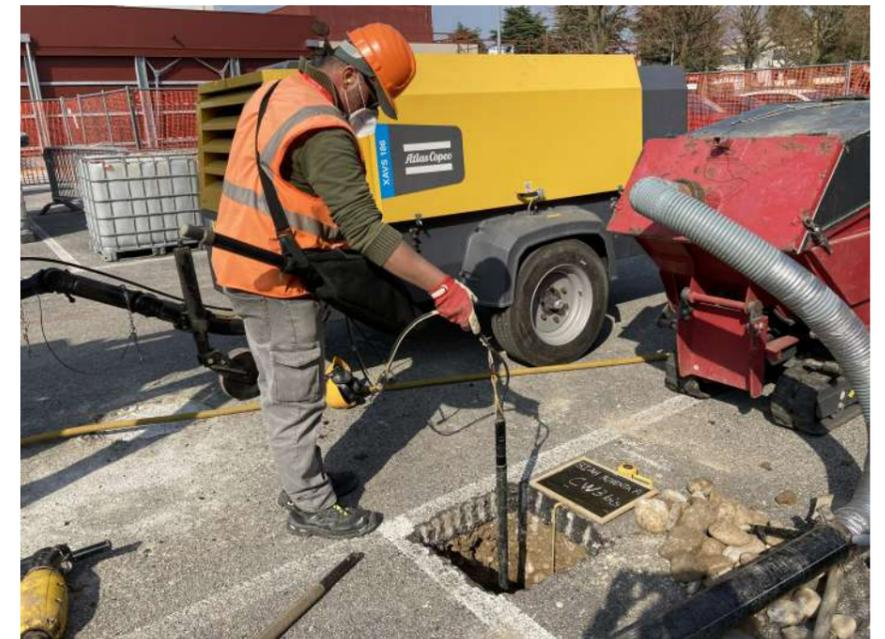
Pre scavo per estrazione vecchi piezometri / Vacuum excavation at monitoring wells to be removed
