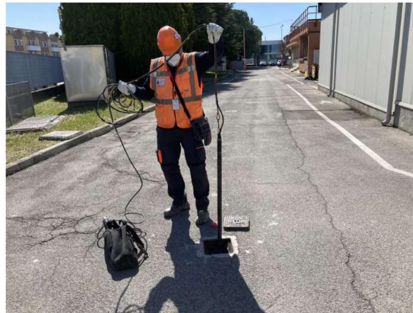
Indagine magnetometrica su nuovi piezometri da installare / Magnetometric Survey for the installation of new monitoring wells
