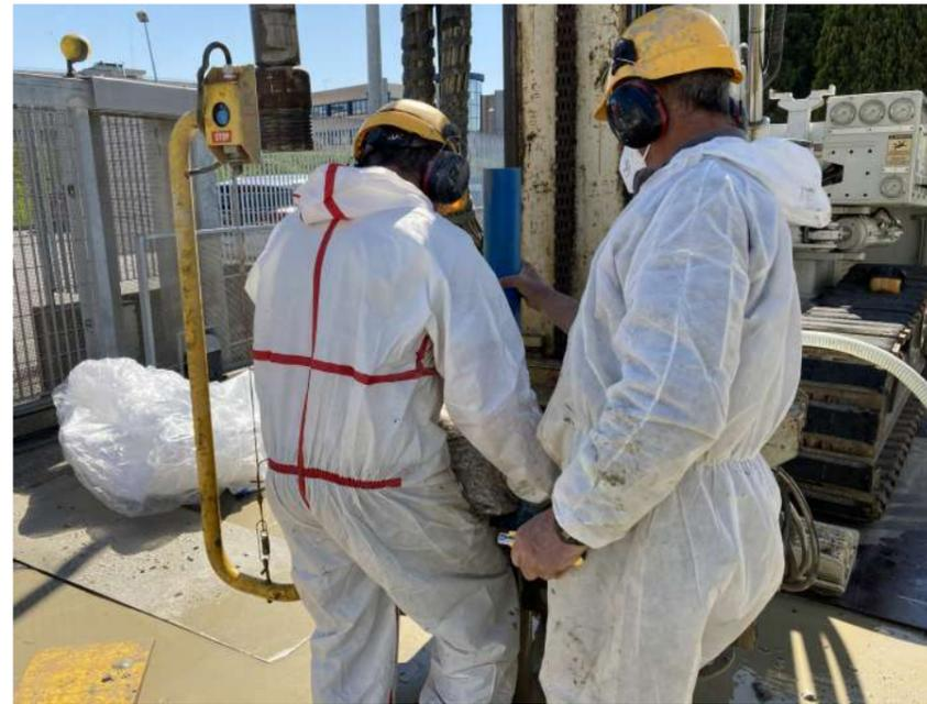
Sviluppo dei nuovi piezometri / Developing of new installed monitoring wells
