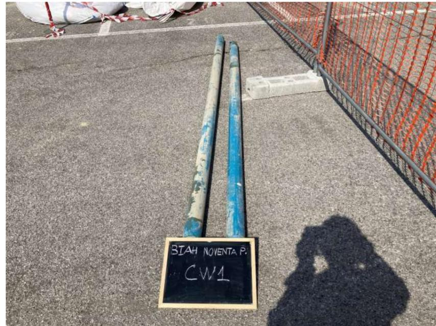
Piezometro estratto CW2 (due tubi da 3 metri ciascuno, uno cieco e l'altro fessurato) / Removed Monitoring well CW2 (a 3m-long riser and a 3m-long screen)
